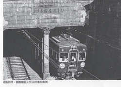
昭和3年(昭和3年) 地下通路完成後の様子
