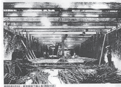
昭和3年(昭和3年) 地下通路建設中(左:新築駅舎)
