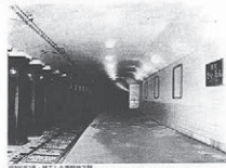
昭和3年(昭和3年) 地下通路完成後の様子
