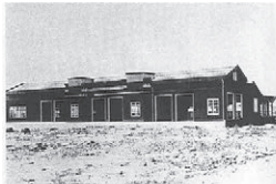
昭和3年(昭和3年) 駅舎建設中(左:新築駅舎)
